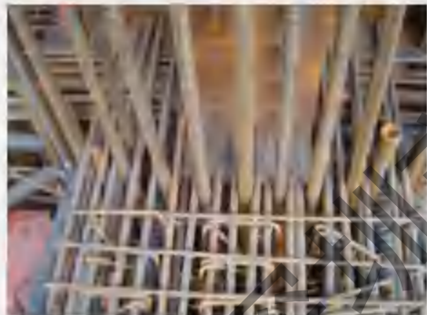
劲性钢-混凝土柱(计现浇)
