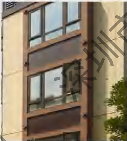
预制墙瓷砖反打
