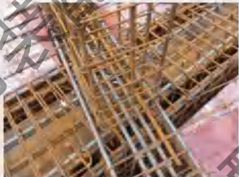
劲性钢-混凝土梁(计现浇)
